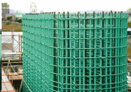
県道高速名古屋新宝線 天白大橋下部工事（愛知）
