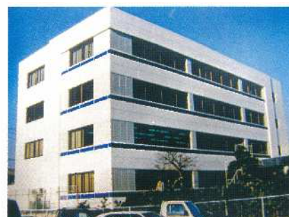
ビル外装パネルの塗装 セラミック塗装(愛知)
