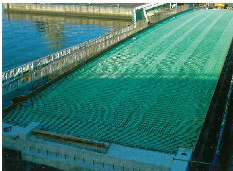
田子の浦港改善（重要）事業沼川橋上部工事（静岡）
