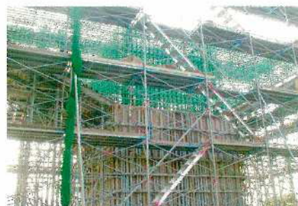
衣浦西部高架橋下部工事（愛知）
