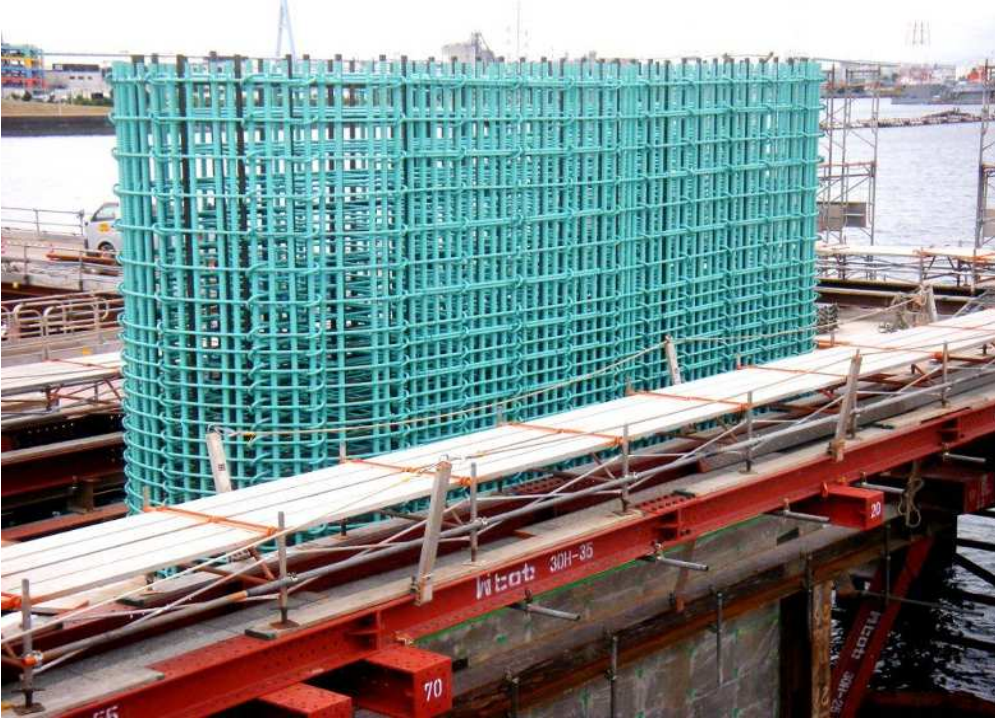
県道高速名古屋神宝線 天白大橋下部工（愛知県）
