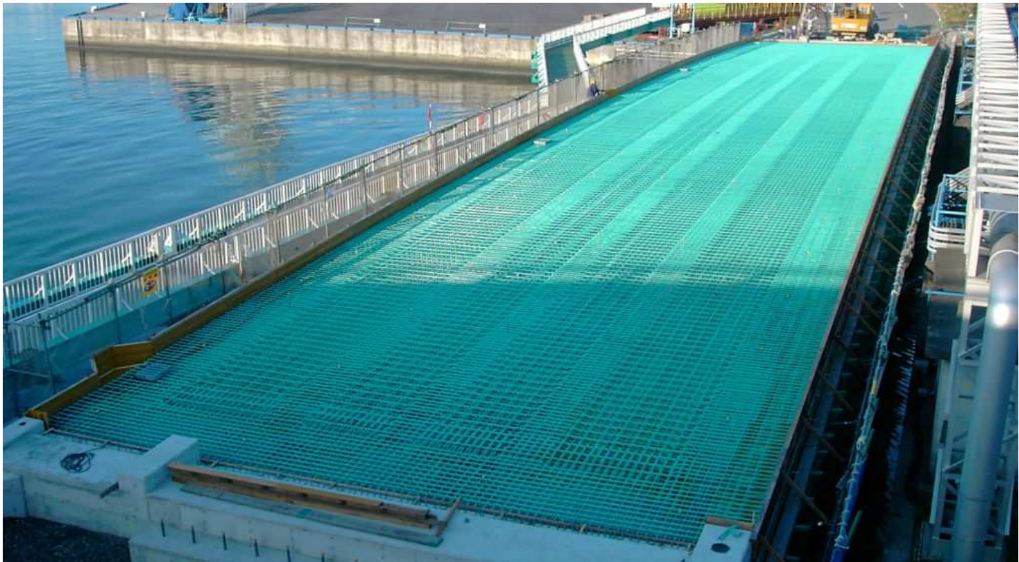
田子の浦港 沼川橋上部工（静岡県）
