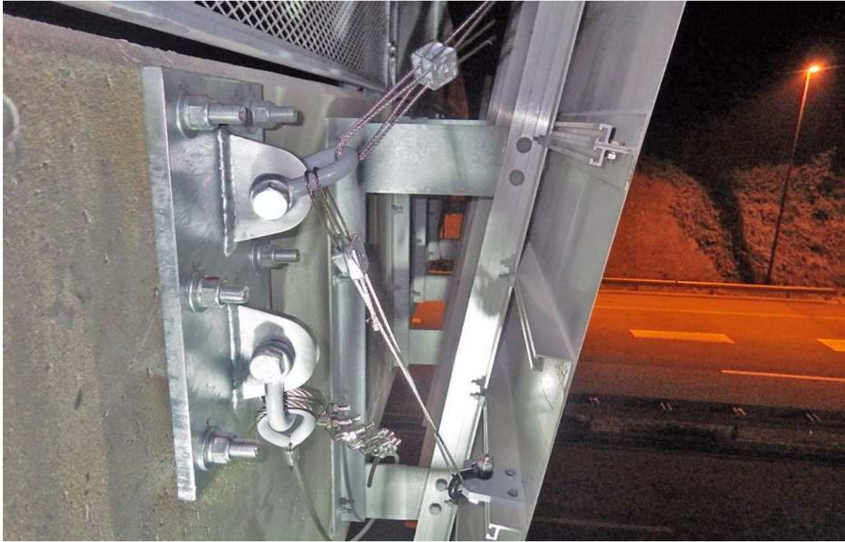
標識板落下防止対策
