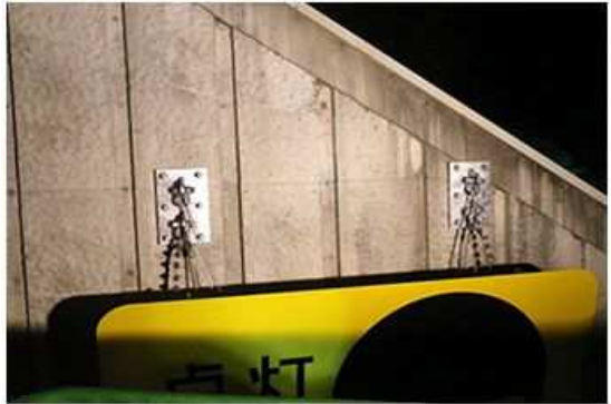
標識板落下防止対策
