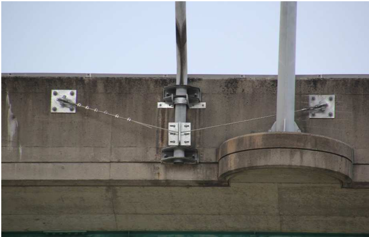
支柱落下防止対策
