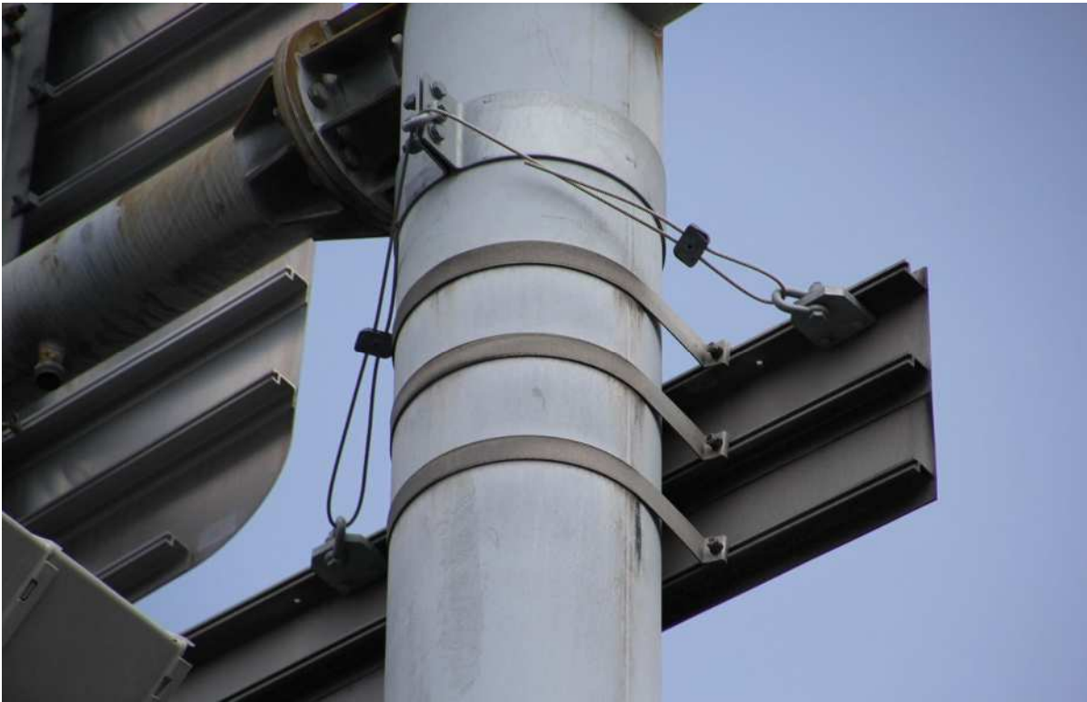
標識板落下防止対策
